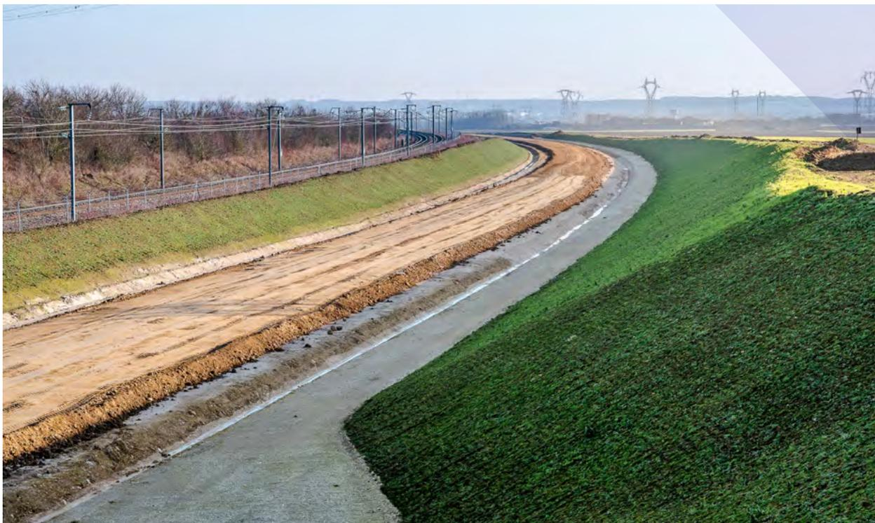
L'ensemencement des talus est un enjeu de sécurité vis à vis de la stabilité des terrains et de l'emportement de sols par les eaux de ruissellement.
