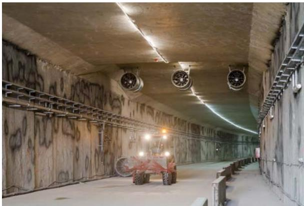
de désenfumage continuent avec la finition de la partie gros œuvre du bâtiment et la pose des équipements d'extraction. Après la mise en service des nouvelles voies de garage RER B en zone L2, les équipements ferroviaires (caténaire, signalisation, voie, ballast...) ont été démantelés. Les travaux de raccordement de l'usine et du système de désenfumage ont ainsi pu être lancés, dès novembre.
