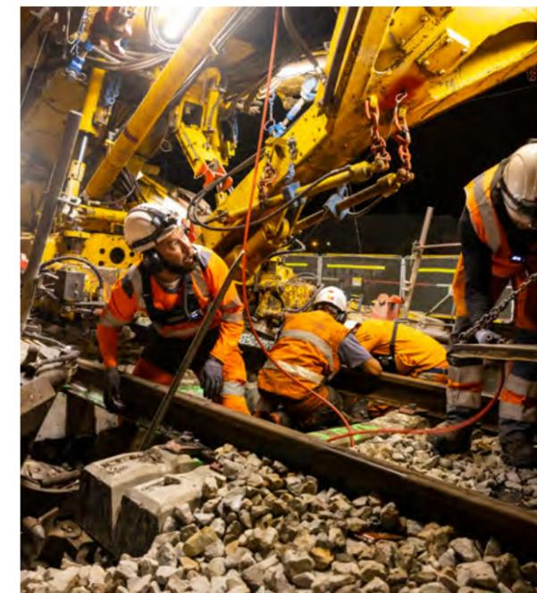
La modernisation de plus de 4,5 km de voies et ballast a été réalisée en totalité pendant trois semaines durant l'été. Elle a concerné deux zones : 3,4 km environ entre Le Bourget et Blanc-Mesnil sur les voies du RER B, du transilien Ligne K et les voies de fret dans les deux sens et plus d'un kilomètre à La Courneuve. Pour l'ensemble de la zone, cela représente 545 tonnes de rails, 7 600 traverses en béton et 11 350 tonnes de ballast.
